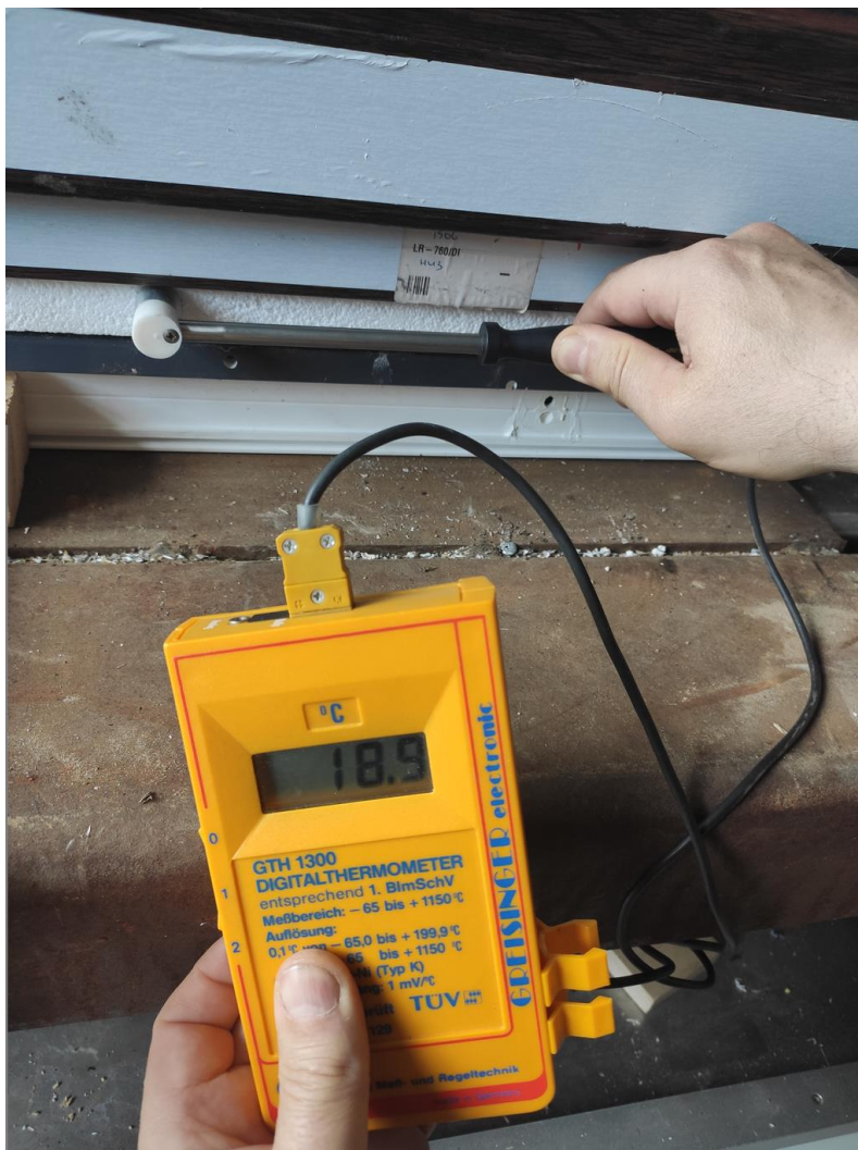
Рис. 9. Оконный блок Deseuninck Favorit Space. Замер температуры поверхности подставочного монтажного профиля СОМРАСFOAM®.
