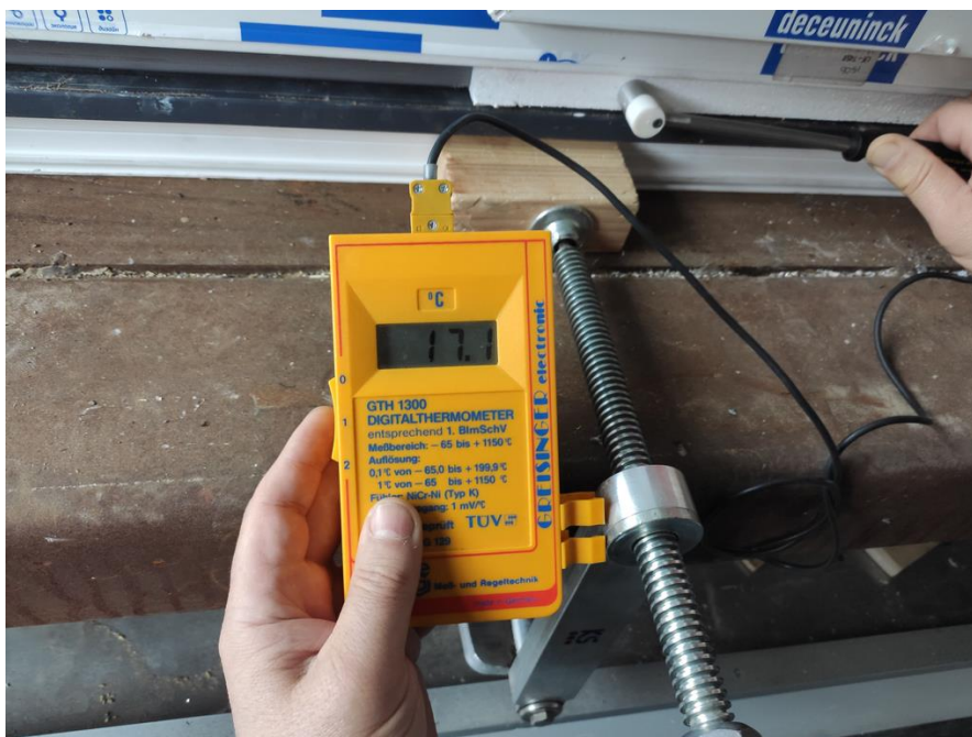
Рис. 22. Оконный блок Vautes Neo. Замер температуры поверхности подставочного монтажного профиля COMPASFOAM®.
