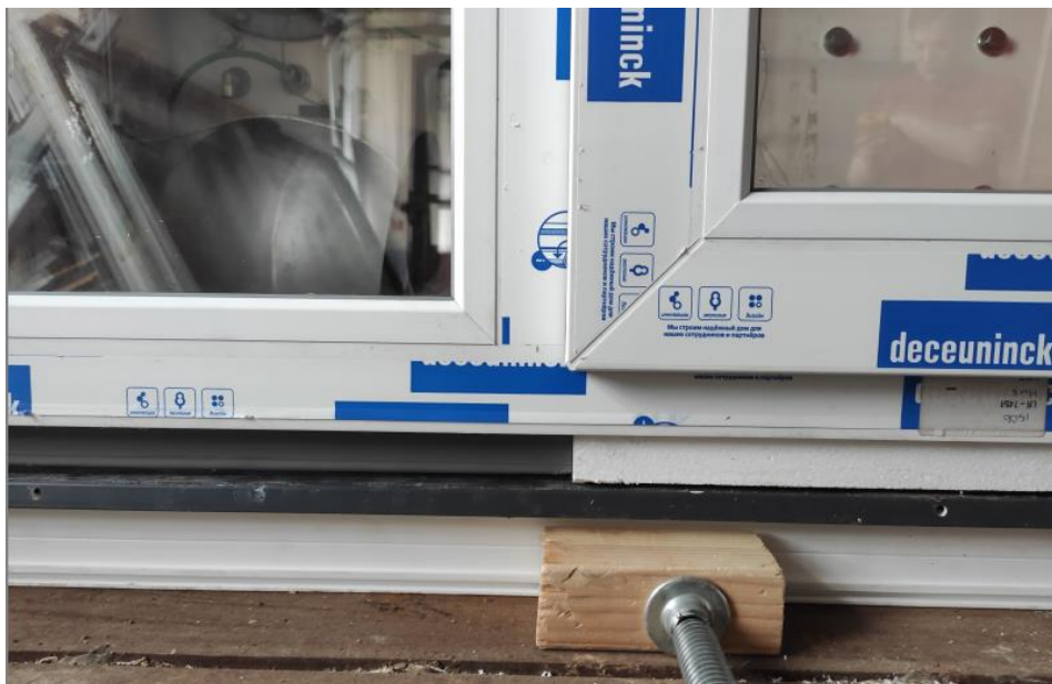
Рис. 18. Оконный блок Vautes Neo. Подставочные профиля COMRACFOAM® и USTK 25, установленные на одном оконном блоке.
