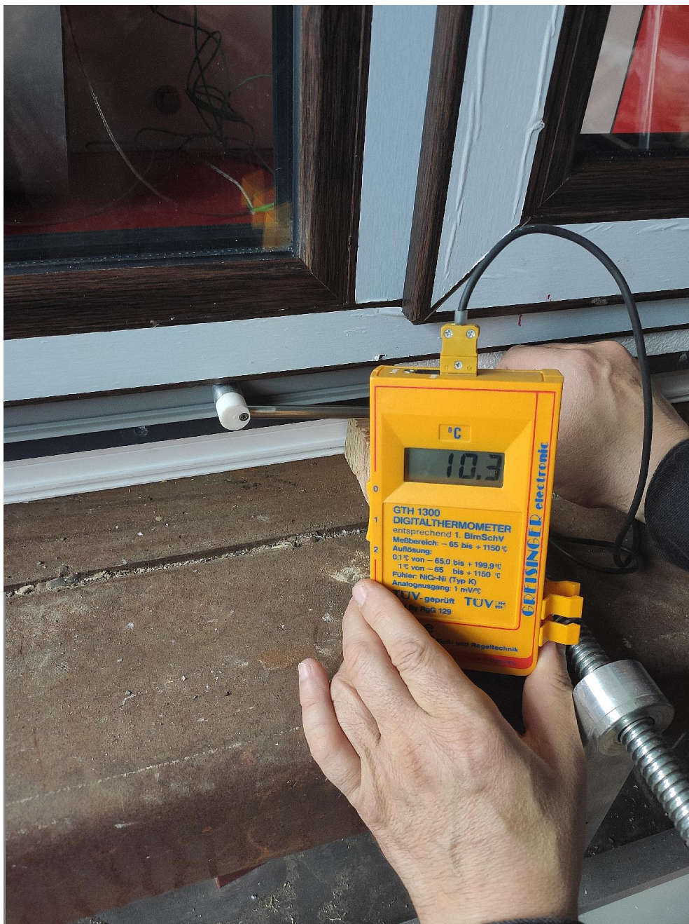
Рис. 10. Оконный блок Deseuninck Favorit Space. Замер температуры поверхности стандартного подставочного монтажного профиля USTK 25.
