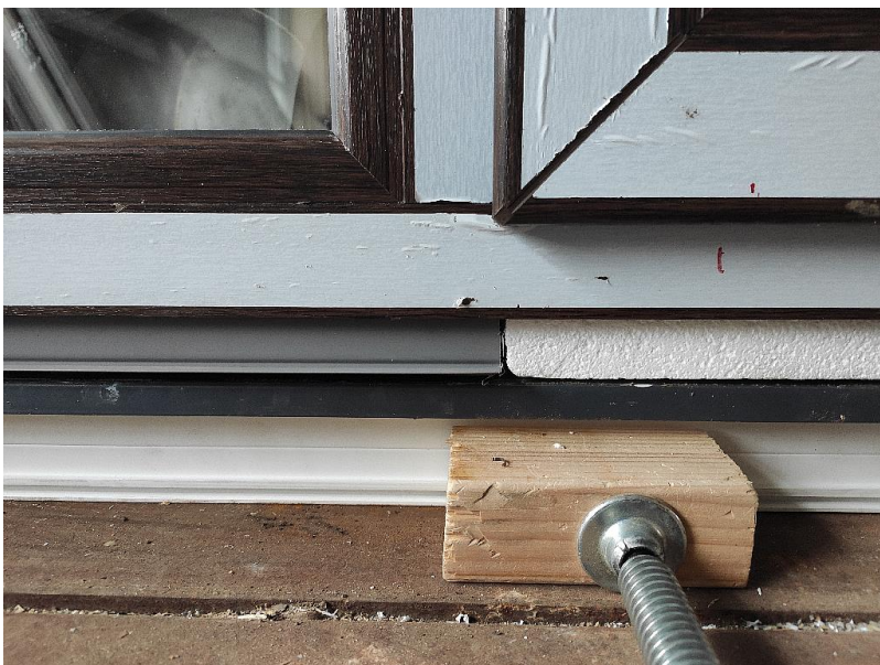
Рис. 5. Оконный блок Deseuninck Favorit Space. Подставочные профили COMRACFOAM® и USTK 25, установленные на одном оконном блоке.
